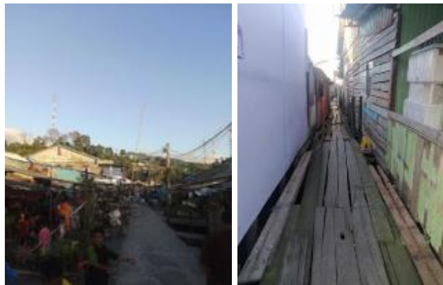
Gambar 2 Jalan Lingkungan Perkerasan Beton dan Titian Kayu
