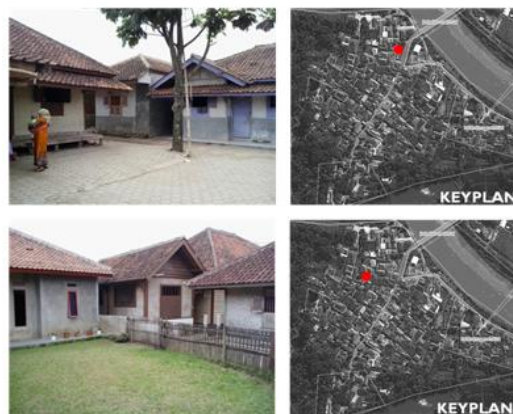
Gambar 4. Rumah-rumah sebelah utara di Kampung Mahmud
