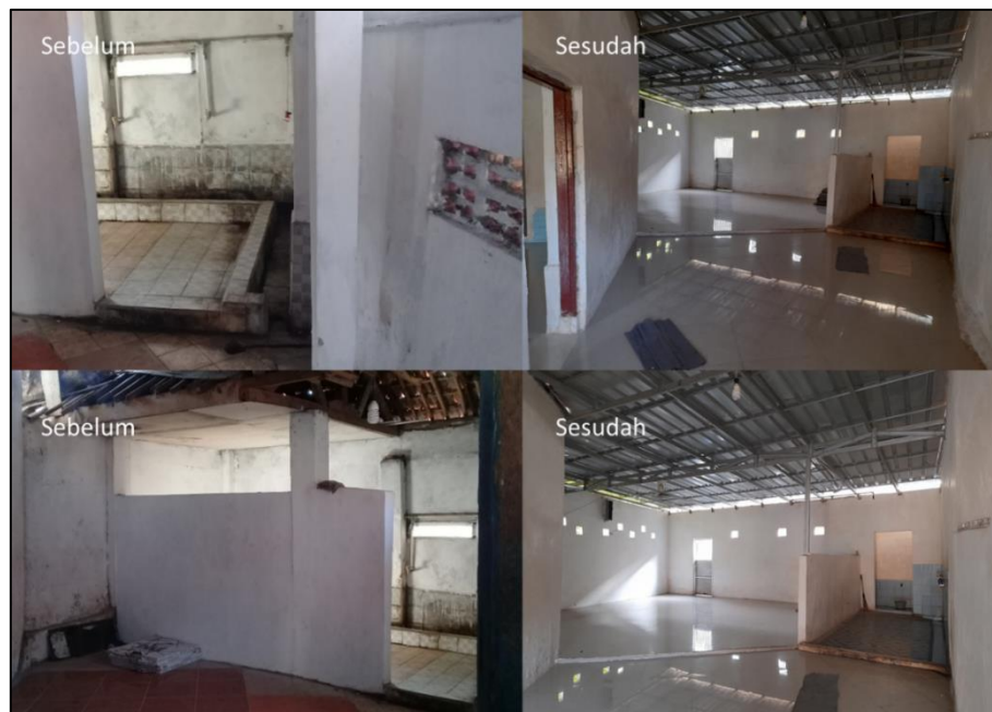
Gambar 7. Perubahan kondisi bangunan sebelum dan sesudah renovasi.
