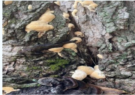
Gambar 7 Tipe kerusakan konk pada pohon kotak pasir di jalan Tadjimalela.
